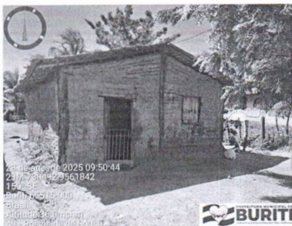
Figura 1: Foto do Terreno
